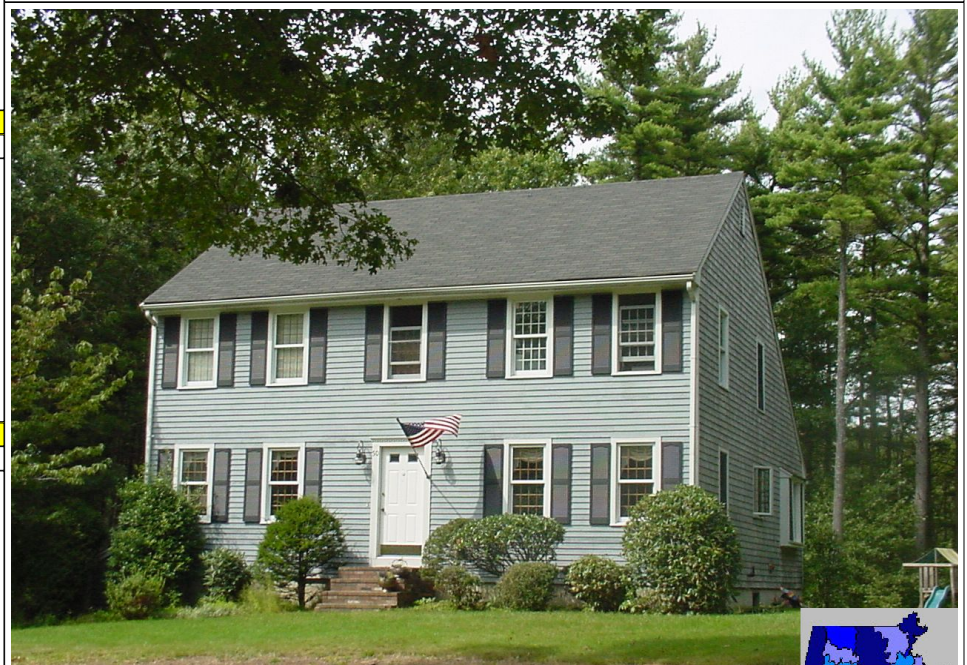
50 MILL POND LN
